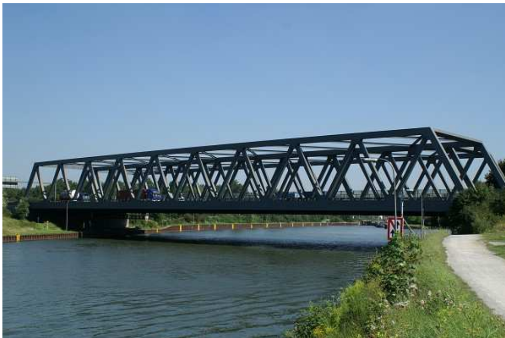
Figura 38: Ponte rodoviária metálica sobre o canal Rhin-Herne
