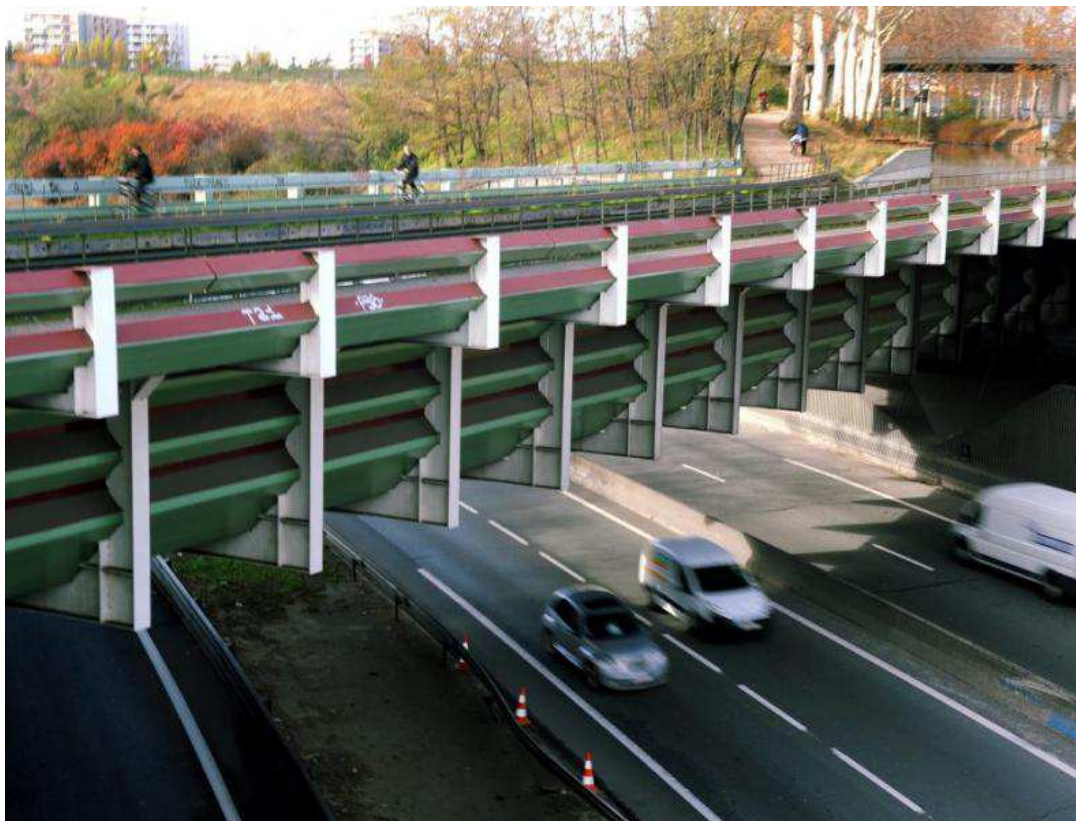
Figura 34: Ponte-canal metálica dos Herbettes (França)
