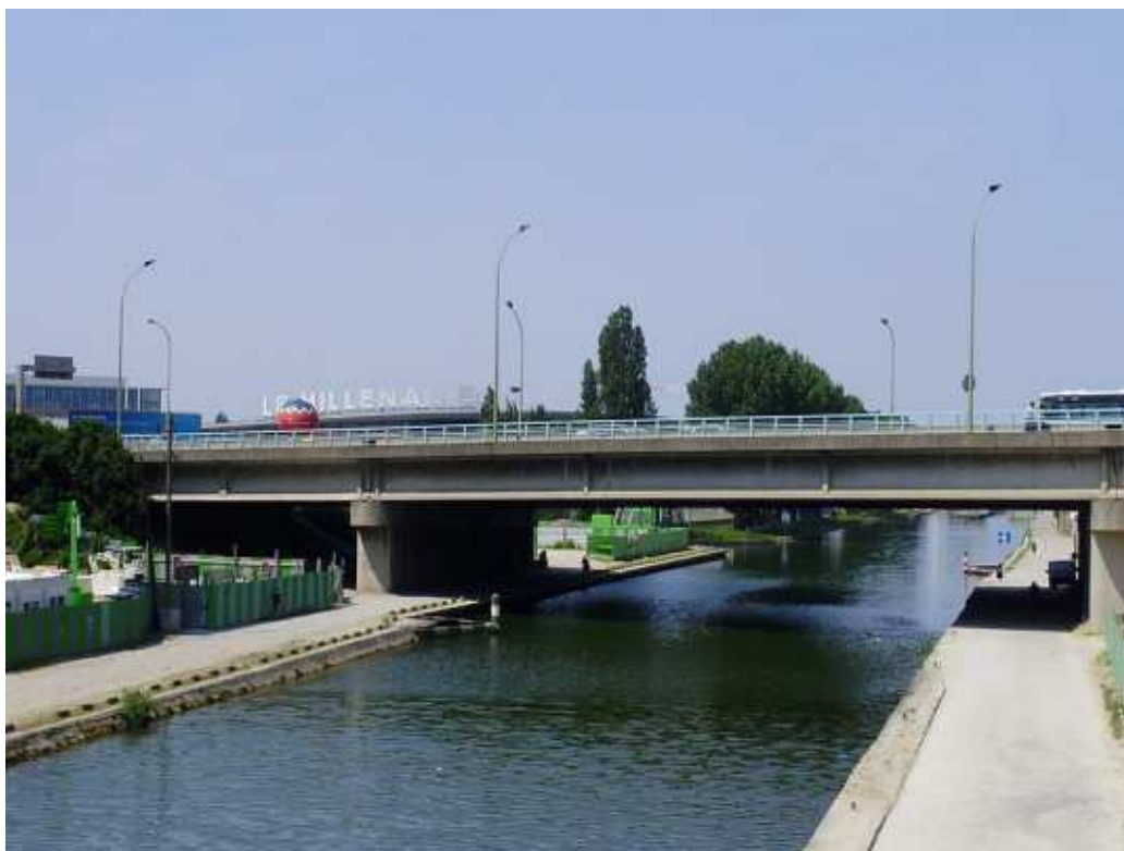
Figura 39: Ponte rodoviária de concreto sobre o canal Saint Denis (França).
