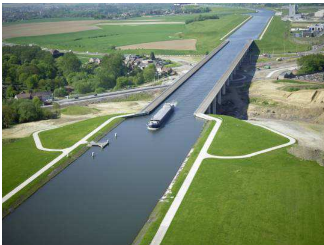
Figura 35: Ponte-canal de concreto armado do Sart (Bélgica).
