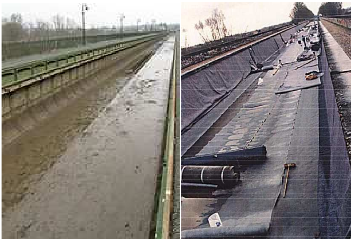
Figura 33: A esquerda a inspeção da ponte-canal de Briare (França) e à direita colocação de uma manta para estanqueidade da ponte-canal de Cacor (França)
